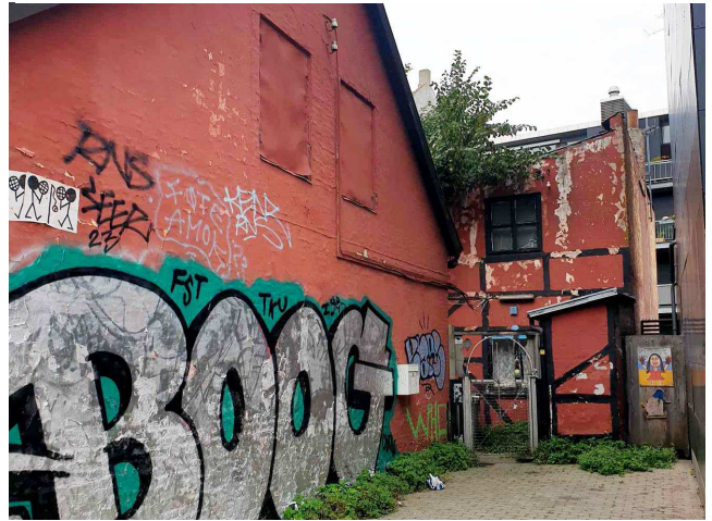
Forhusets endegavl, hvor to vinduer er blændet af. I baggrunden ses baghuset. Imellem er der indgang til gården.
