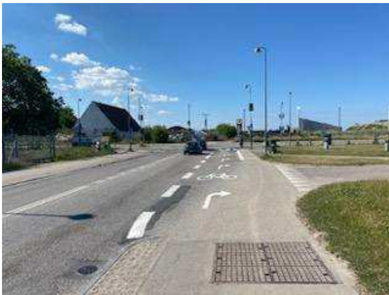
Figur 2: Krydset Prags Boulevard/Amager Strandvej set fra Strandvej.
