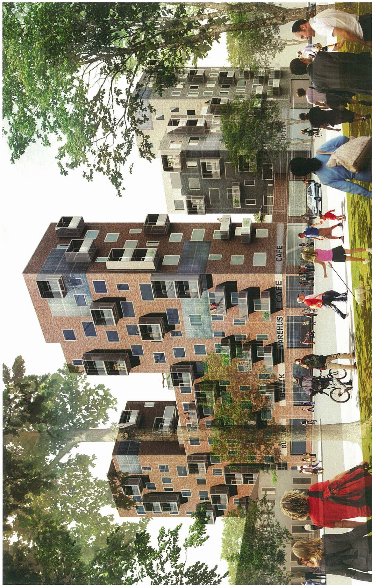
▲ Illustration af muligt bygningsudtryk hvor der arbejdes med udenpå liggende altaner for at skabe dybdevirkning på facaden.
