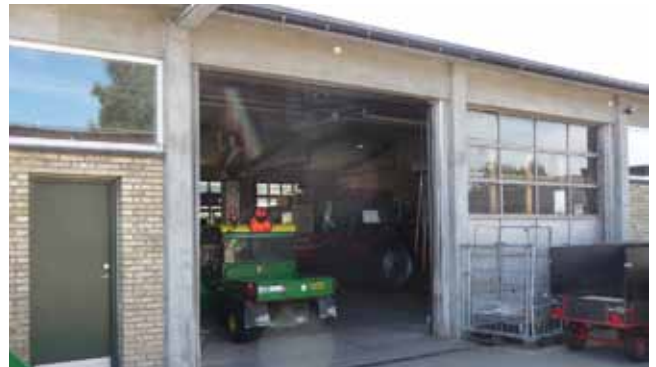
Garagebygning vest for bevaringsværdig bebyggelse, bygning 94, nedrives.
