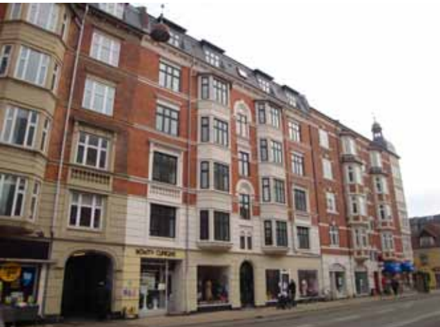
Amagerbrogade 125-133 opført 1904-1907 har høj bevaringsværdi
