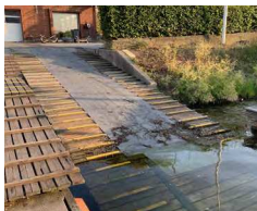
Eksisterende bådrampe, flydepontoner, rampe til pontoner, og bolværk
