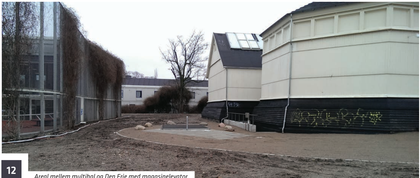
Areal mellem multihal og Den Frie med magasinelevator
