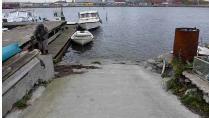
Eksisterende sliske i betonkanten
