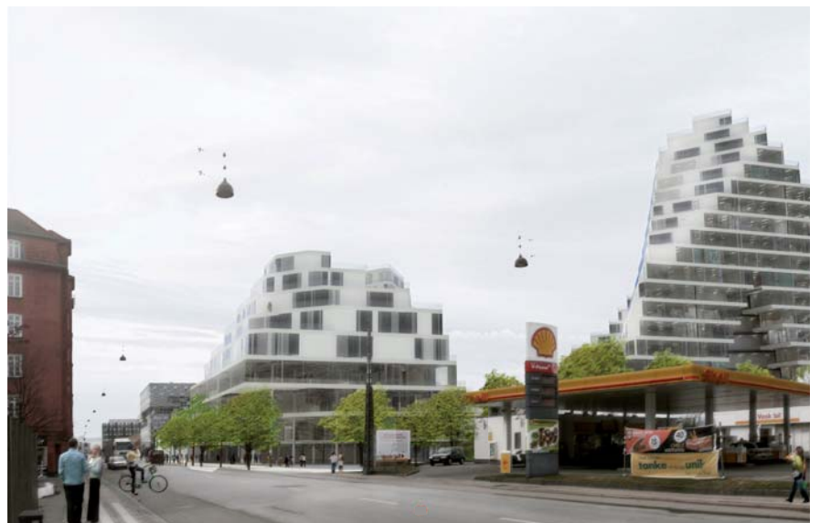
Batteriet set fra Amagerfælledvej (illustr. BIG)
