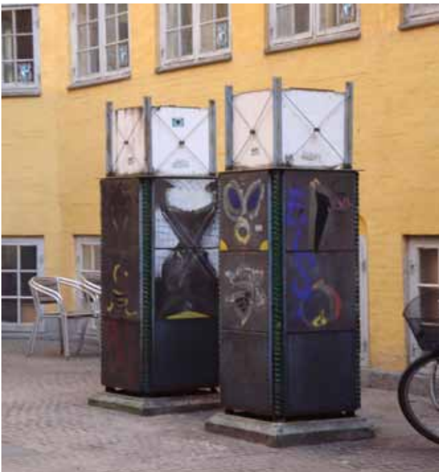
Affaldshåndtering. Eksempel på centralsug for affald i lokalplanområdet.
