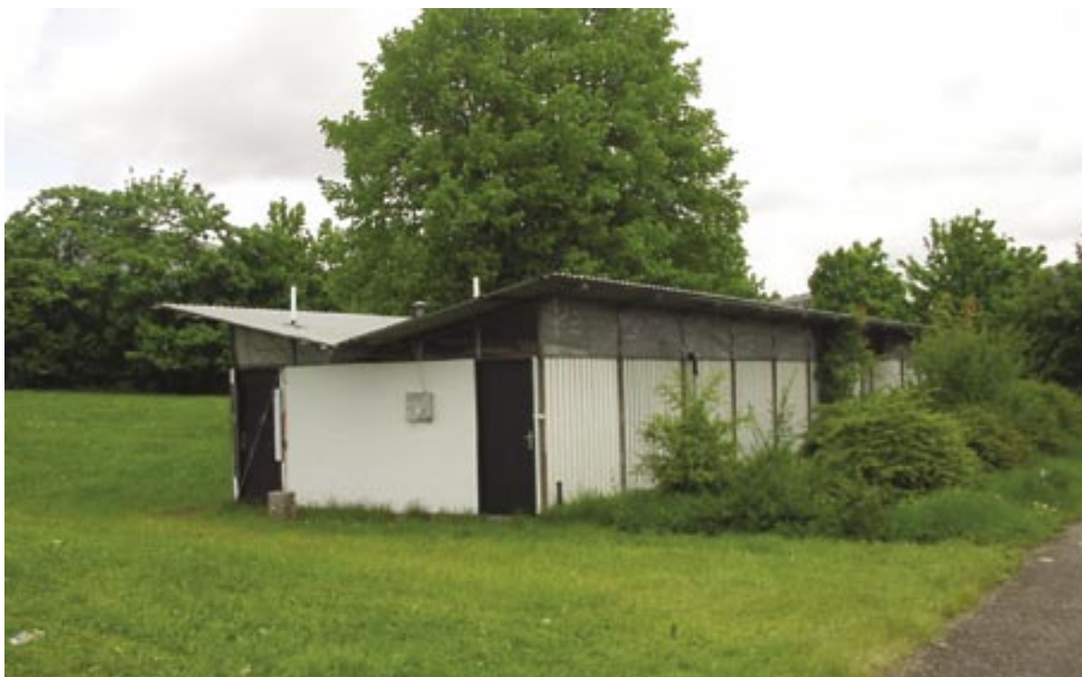
Nuværende toilet og badefaciliteter er nedslidte og skal udskiftes med nye tidsvarende.
