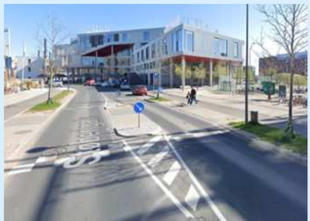
Støttepunkt- som midterhelle ved skolen i Sydhavnen
