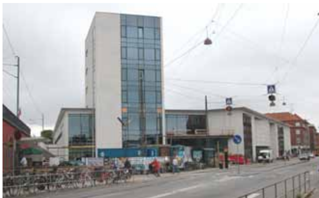
Frode Jakobsens plads med den ombyggede biogafbygning.
