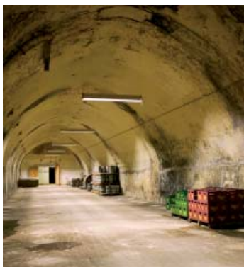
Kælderen under Rød Lagerbygning.
