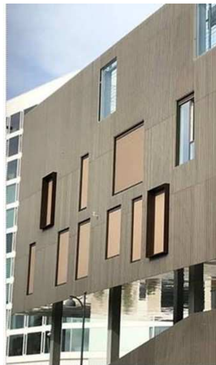
På størstedelen af facaderne udføres solafskærmning med udvendige, lysegrå screens. Facader vil derfor fremstå delvist lukkede, når der er behov for solafskærmning. Foto viser eksempel på udvendige screens ved Islands Brygges Skole.
