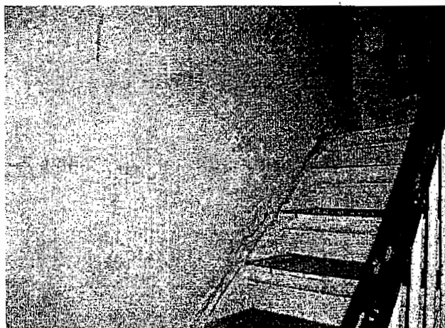
Nedgang til kælder
