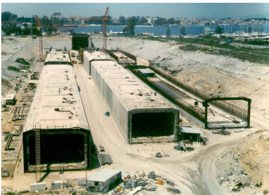
Figur 6.15 Preveza-Aktio tunnel i Grækenland – Bygning af tunnelementer i separat dok
