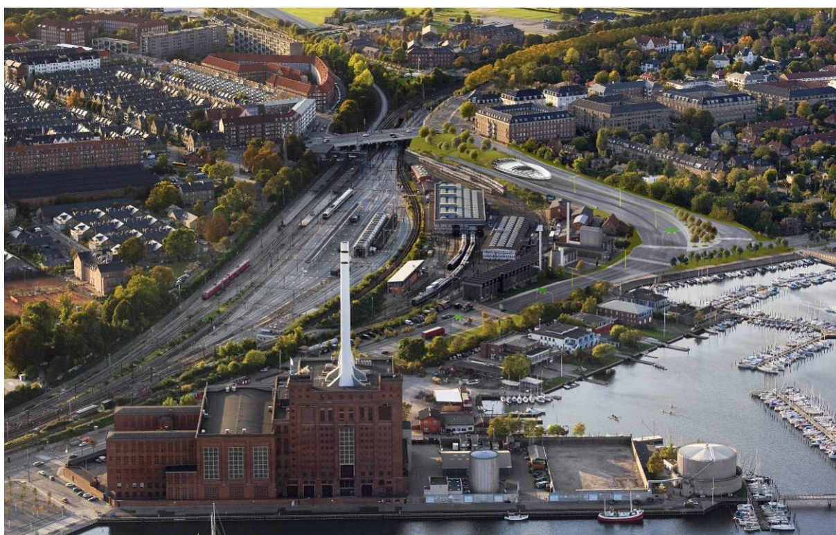
Figur 12.14 Rampeanlæg ved Strandvænget (Schönherr Landskab).
