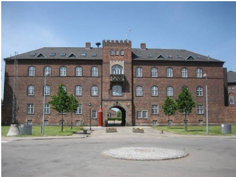
Figur 6.6 Kasernens hovedbygning. Tunnelen vil passere under gavlen til venstre
