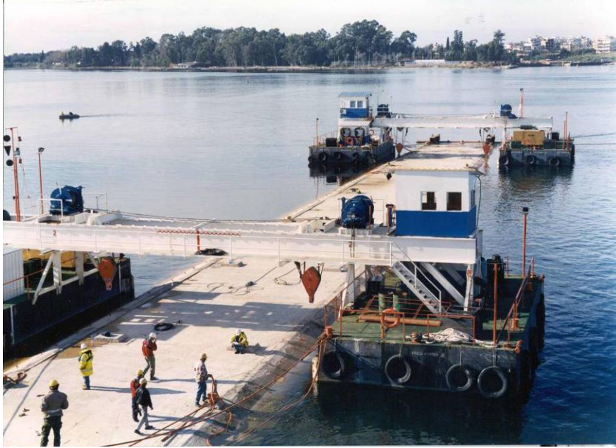
Figur 6.17 Preveza-Aktio tunnel Grækenland – Udflåding af tunnelelement
