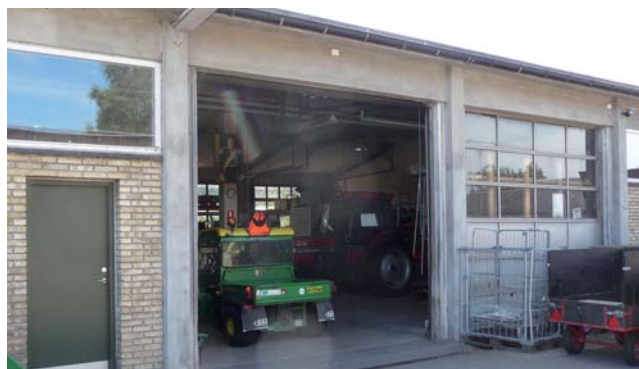
Garagebygning vest for bevaringsværdig bebyggelse, bygning 94, nedrives.
