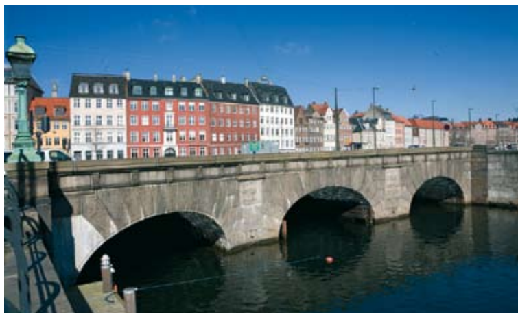
Oversigtsbillede af klassisk buebro ved Stormgade.
