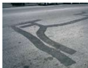
Reparation af revner.
