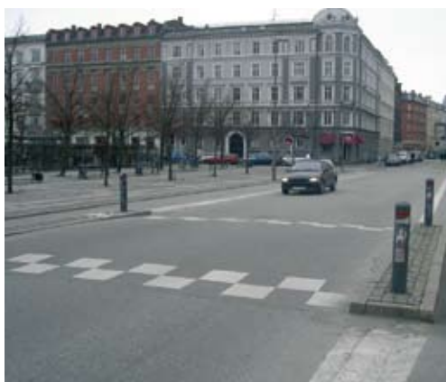
Nyt hastighedsbump, Vendersgade
