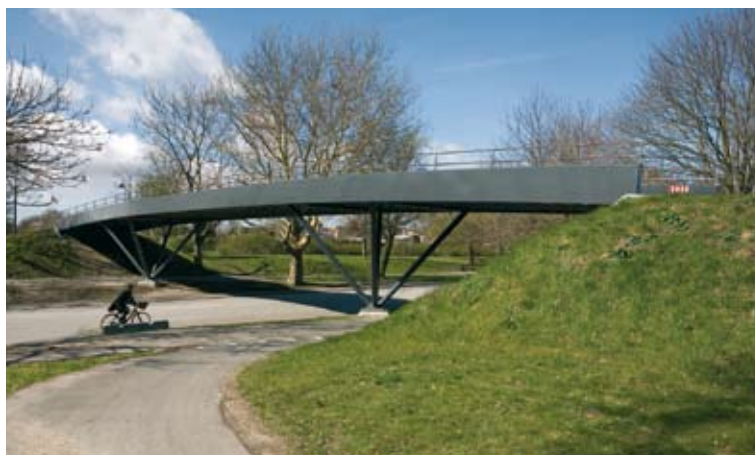
Gangbro over Lersø Parkallé.
