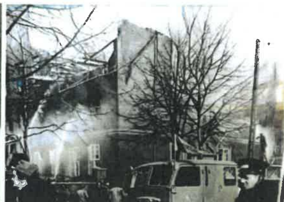
S-2 Redningsarbejdet den Franske skole
