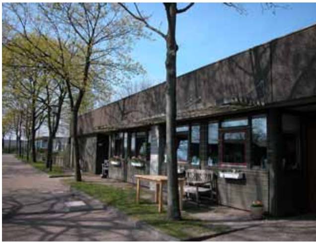
En af atriumhusene ved den interne fordelingsvej i Sundbyvangområdet. Bebyggelsen her skal fjernes og erstattes af nybyggeri.
