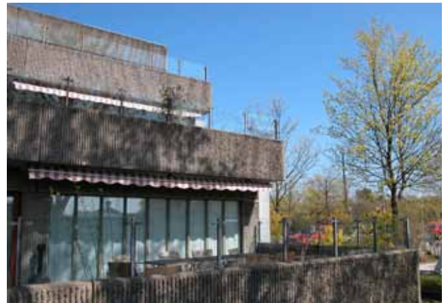
Det eksisterende byggeri er terrasseret mod kolonihavebebyggelsen og villabebyggelsen
