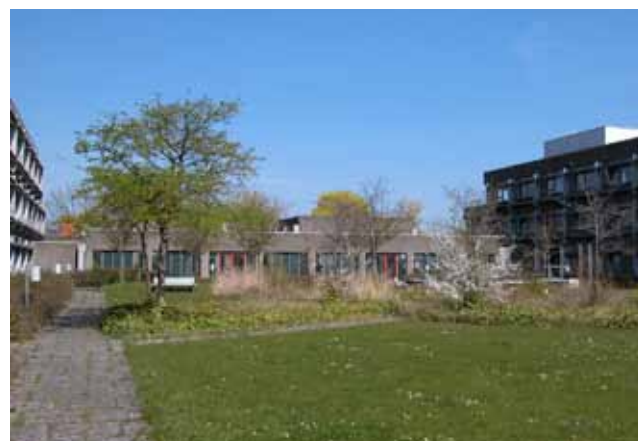
Mellem de eksisterende boligblokke ligger en 1-etages fordelingsgang med fællesfaciliteter til institutionen Sundbygård. Disse fællesfaciliteter skal indrettes i de bygninger der bevares i forbindelse med ombygningen.
