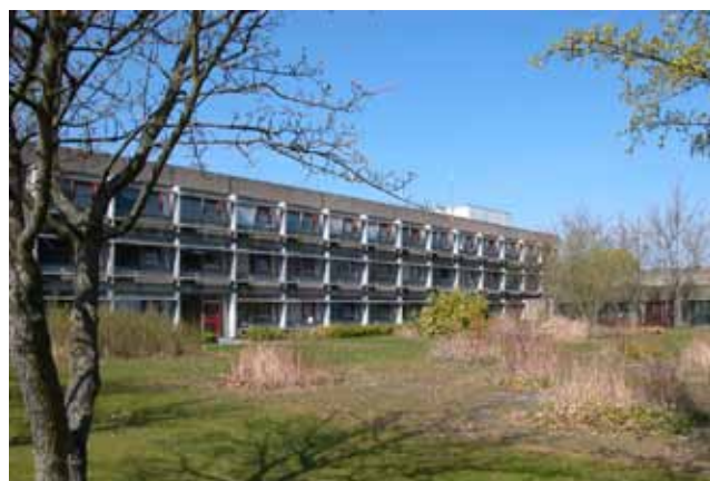
Eksisterende haverum og byggeri som skal nedrives i forbindelse med ombygningsplanerne for Sundbygård. Her skal istedet opføres nyt alment boligbyggeri
