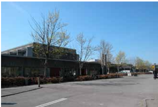
Den eksisterende indkørsel og adgangsforhold til Sundbygård fra Røde Mellemvej.
