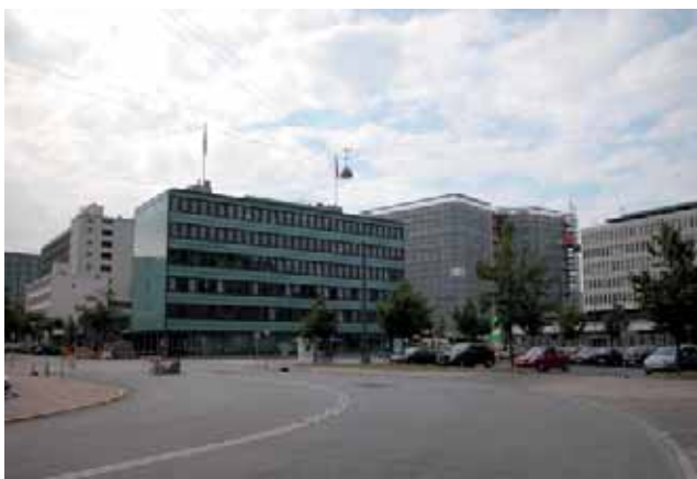
Falckhuset set fra Polititorvet (eksisterende forhold).
