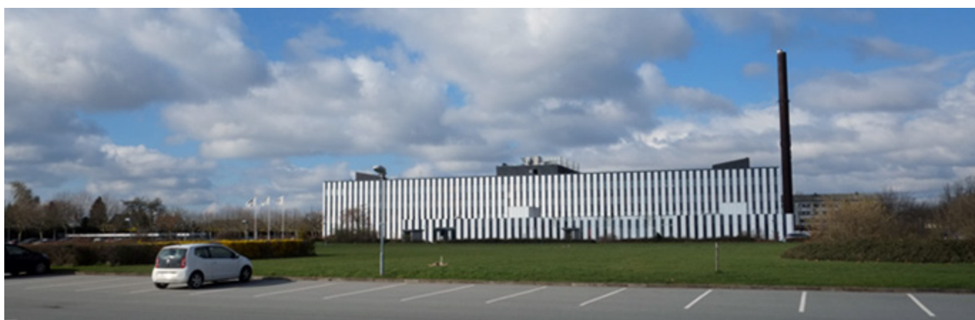
DXC set fra parkeringsarealet ved Retortvej. Foto: Arkitema.
