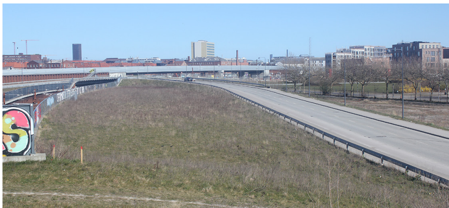
Det kommunale areal set mod øst med Ringstedbanen til venstre og Kulbanevej til højre. Det er denne strækning af Kulbanevej, der forudsættes nedlagt.
