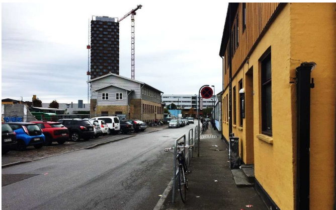
Den midterste del af Drejervej. Til venstre i billedet ses Drejervej 8-10, hvor der bygges nyt. Til højre i billedet ses Drejervej 25, der udpeges som bevaringsværdigt kulturmiljø.
