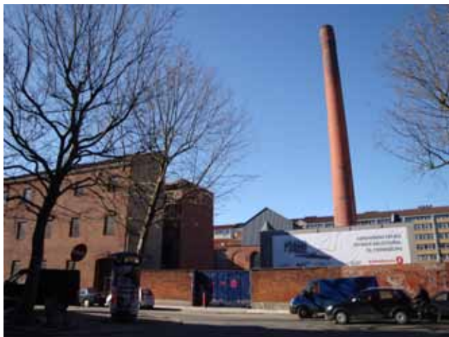
El-værksgrunden i Borgergade overfor lokalplanområdet
