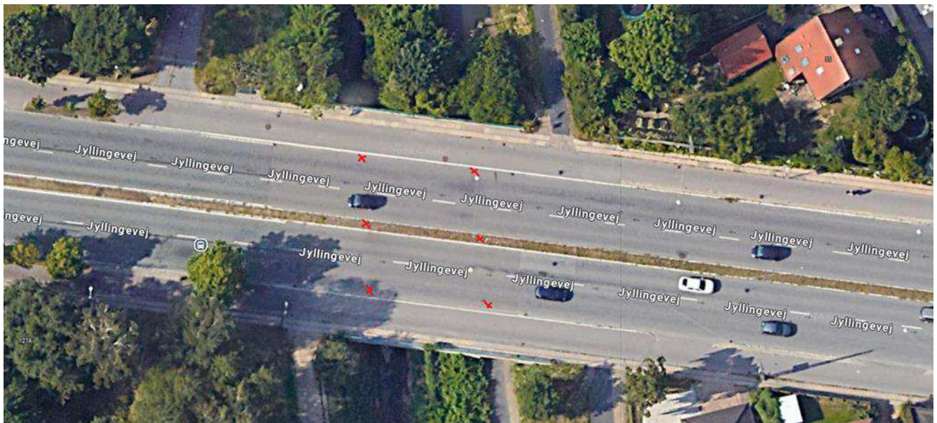
Figur 4.2.1: Placering af prøvegravninger på eksisterende bro
