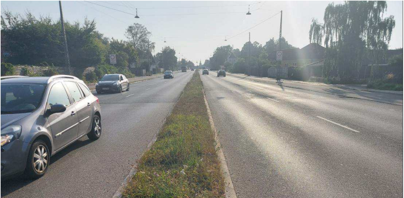
Figur 4.1: Eksisterende vej, billede taget fra besigtigelse d.05.09.2024.
