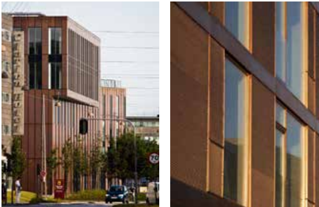
På disse to fotos ses et eksempel på et naturligt materiale i form af kobberfacade. 'Sydporten' i Sydhavnen, Henning Larsen Architects.
