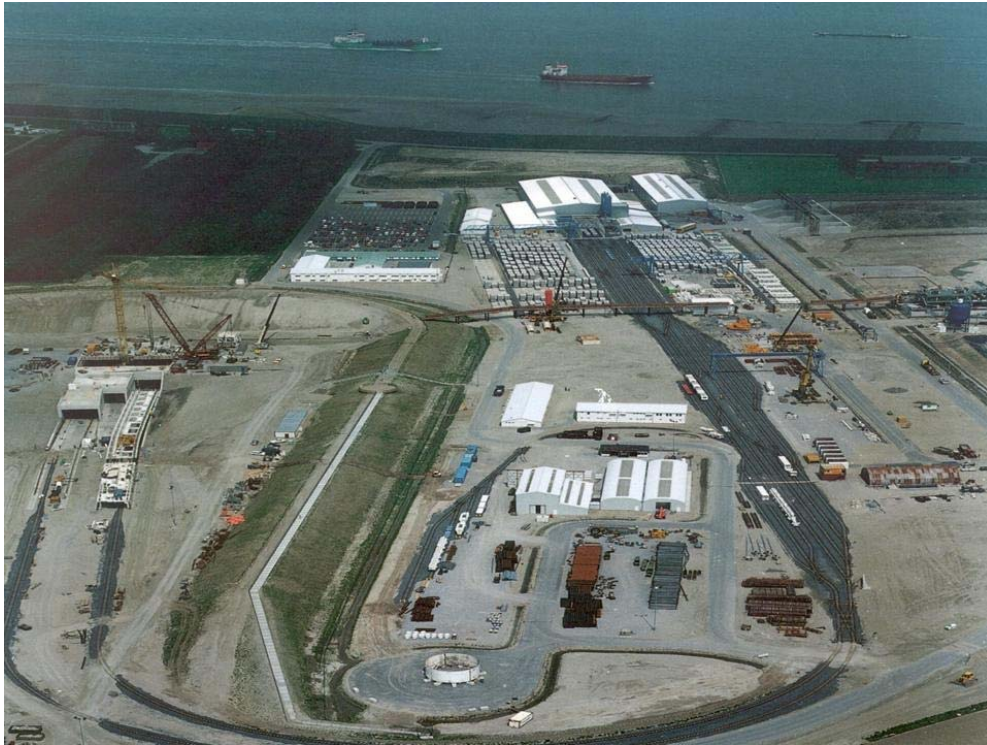
Figur 7.11 Arbejdsplads Westerschelde Tunnel, Nederlandene.
