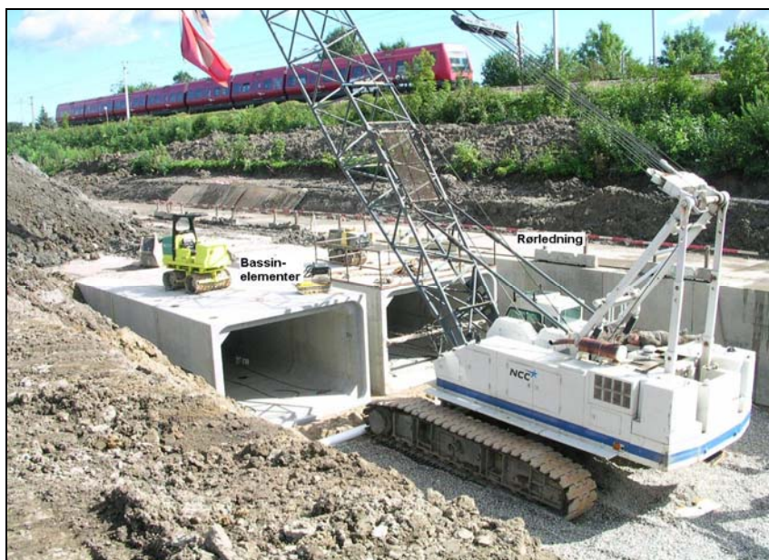
Figur 5.6 Fra rørlægningen af Lersøgrøften
