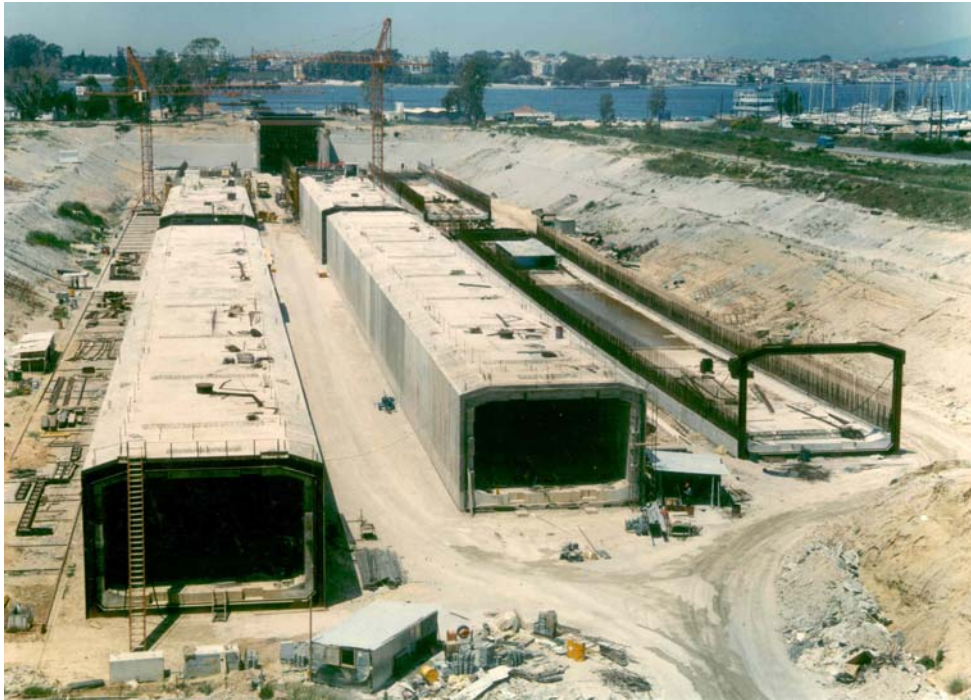
Figur 6.2 Preveza-Aktio tunnel i Grækenland – Bygning af tunnelelementer i separat dok
