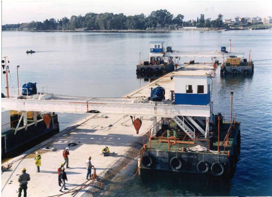
Figur 6.17 Preveza-Aktio tunnel Grækenland - Udflåding af tunnelelement
