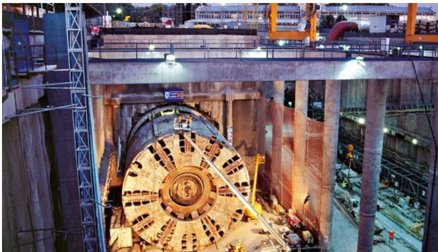
Figur 6.24 Tunnelgennembrud i modtagekammer. Projekt M30 i Madrid
