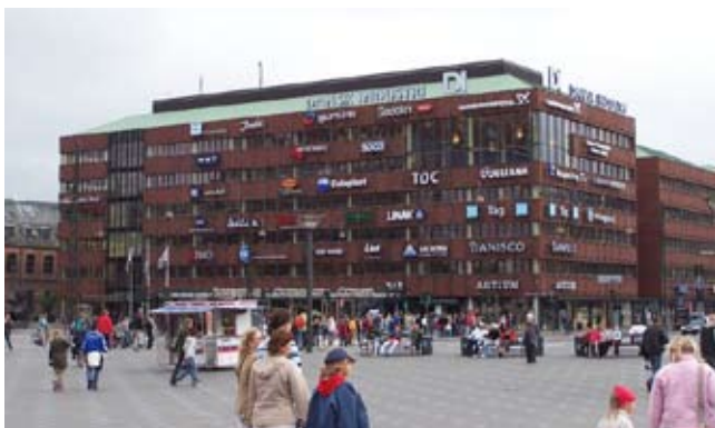
Industriens Hus, opført 1978-80. (Arkitekt Erik Møller).
