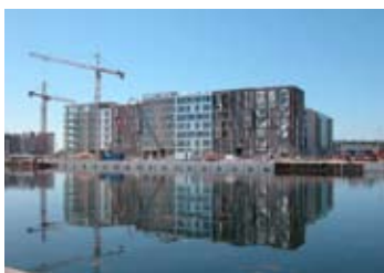
Bebyggelsen på Sluseholmen er ved at tage form. Karré C og E er færdigbyggede, og de resterende karreer på Sluseholmen Nord er under opførelse.
