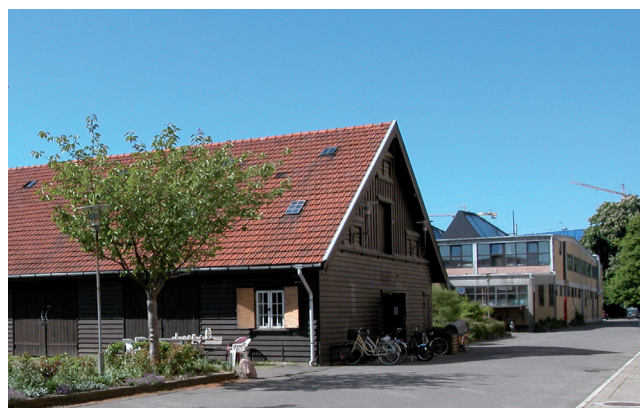
Bevaringsværdig bygning med opbevaring af materiel
