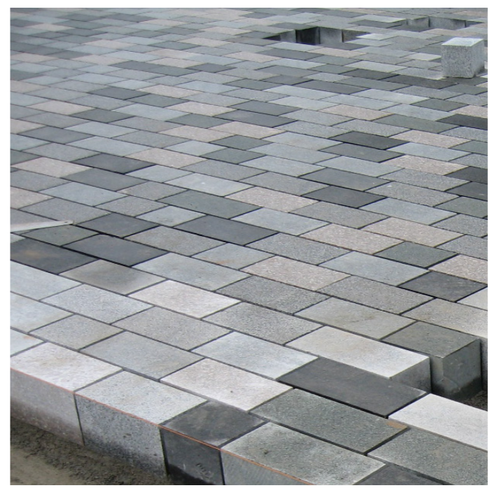
New Road i Brighton med flisebelægning i forskellige grå nuancer.
