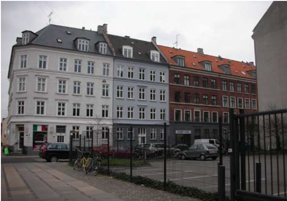
Facader i Fanøgade over for lokalplanområdet.
