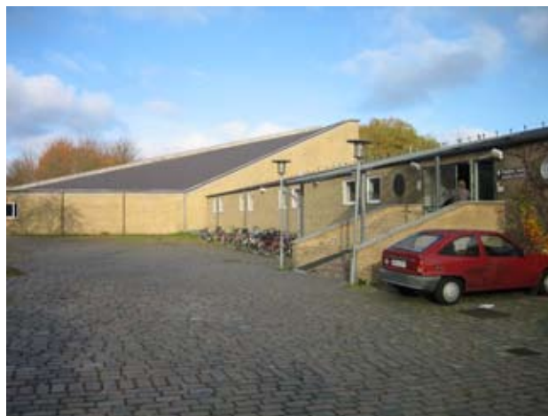
Foto 01 Ankomst - sammenbygning af skole og svømmehal/parkeringsareal.
