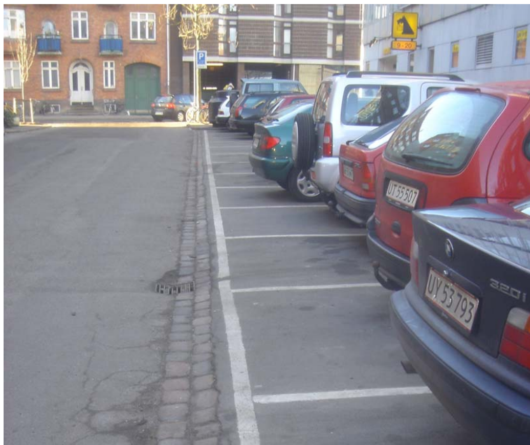
Figur 20. Eksempel i Korsørgade på inddragelse af fortov til parkering og etablering af rampe i brosten mellem kørebane og parkering.
