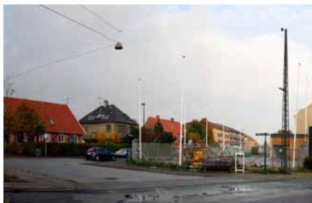
Hjørnet af Vanløse Allé og Apollovej set mod øst med parkeringsarealet i forgrunden.
