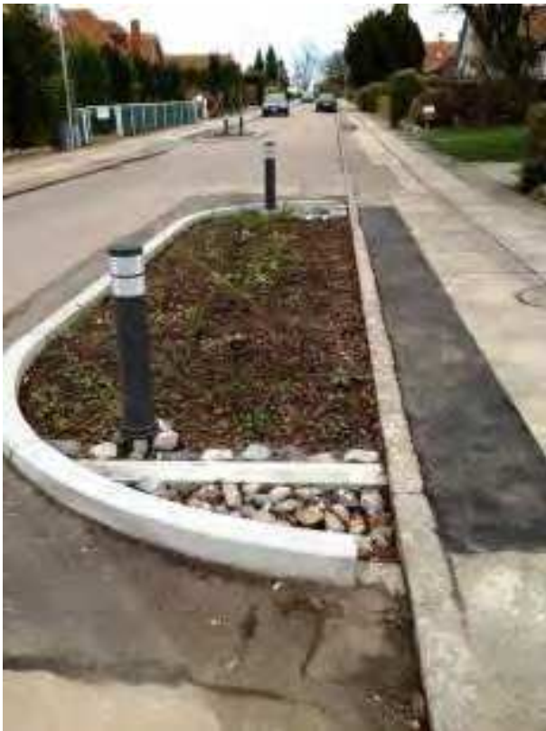
Kantstensbed til opsamling rensning og nedsivning af vejvand. Lokaltet: Lindevang, en villavej i Brøndby. Foto: Simon Toft Ingvertsen
