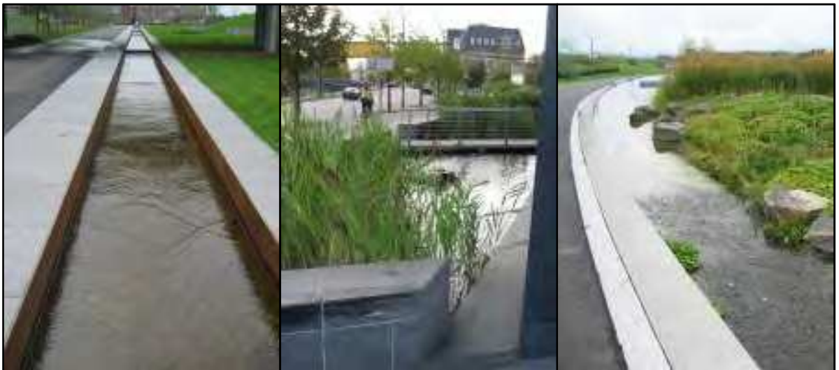
Figur 6.5. Eksempler på mindre våde kanaler langs veje fra Tyskland og Norge. Fotos: Antje Backhaus.
