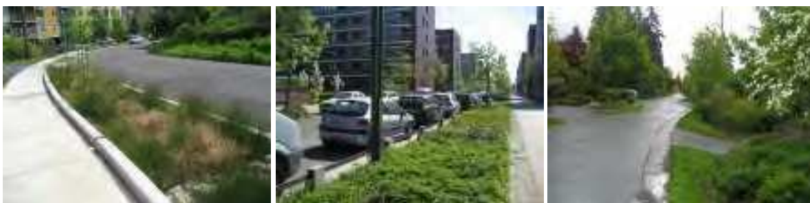
Figur 6.7. Eksempler på regnbede langs veje fra Tyskland og USA. Fotos: Antje Backhaus.
