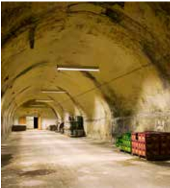
Kælderen under Rød Lagerbygning.
