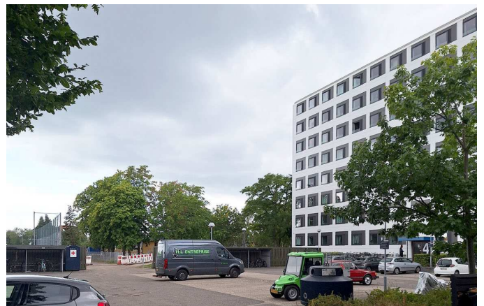
Billede taget mod syd af en del af den østlige parkeringsplads.
