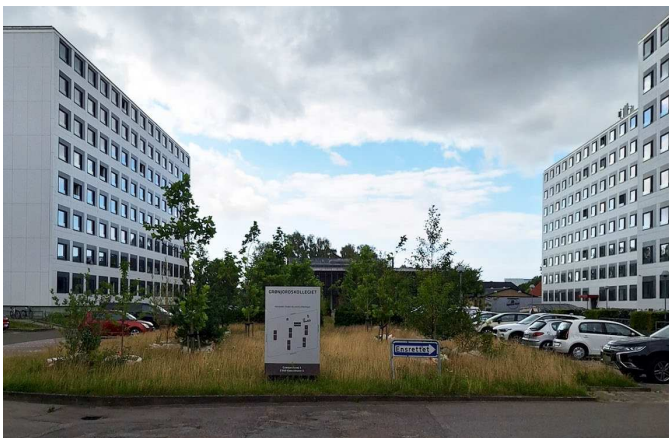
Billede taget mod syd af den centrale parkeringsplads.
