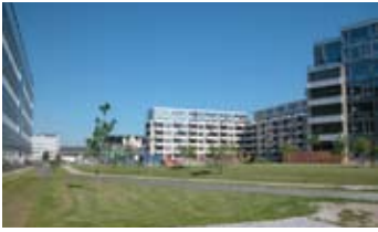
Den grønne kile, hvor den passerer den nyopførte bebyggelse "Teglholms Have". Til venstre i billedet ligger Dong Energy.
