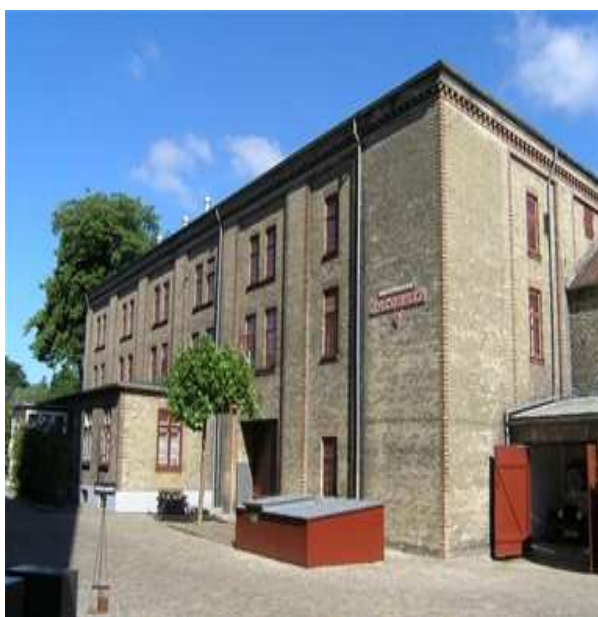
Figur 11-2 Husbryggeriet Jacobsen - I 2005 blev Gamle Carlsbergs Gule Lagerbygning (Opført 1878) ombygget til Carlsbergs Husbryggeri.
