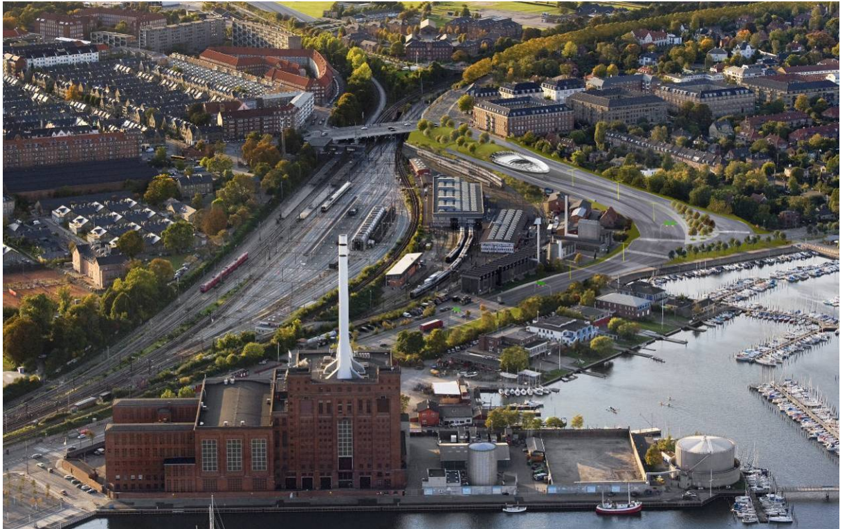
Figur 12.16 Rampeanlæg ved Strandvænget (Schönherr Landskab).
