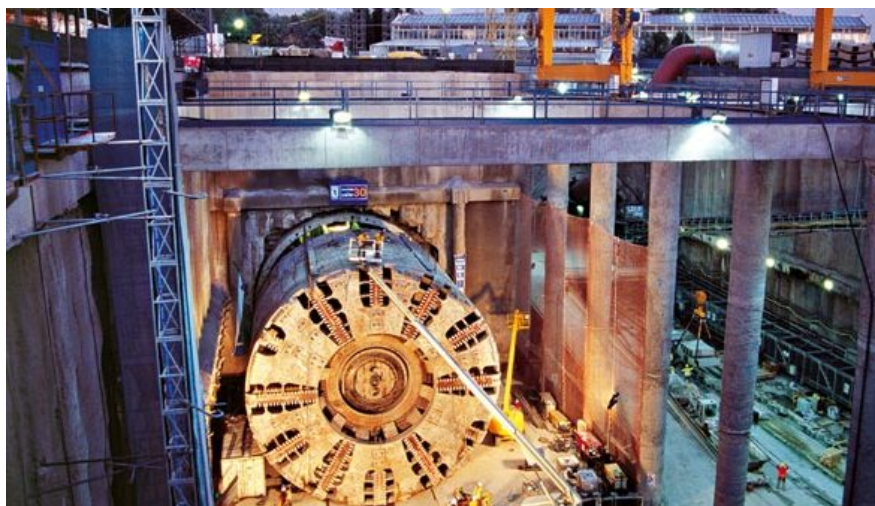
Figur 6.24 Tunnelgennembrud i modtagekammer. Projekt M30 i Madrid
