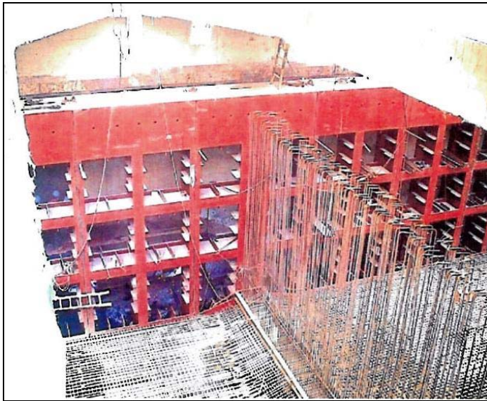
Figur 5.17 Stålramme og segmentbygning i Shanghai
