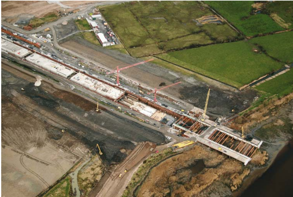
Figur 6.3 Limerick tunnel Irland – Bygning af tunnelelementer i fremtidig rampeområde
