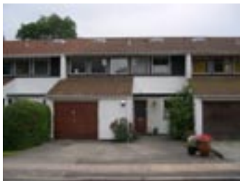
Rækkehus ved Kildevænget med hvide facader og røde tage.
