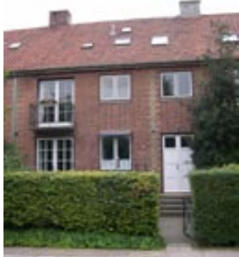
Vestfacade på rækkehus ved Soldalen med mønstre af gule mursten i den røde facade og med den oprindelige hoveddør.
