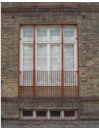
Vindue med karakteristisk, rødmalet støbejernsparti på karreen mellem Østerled og Solvænget.
