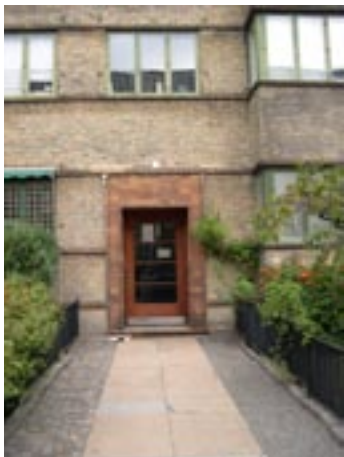
Facadeparti med hoveddør på den nordligste af de 4 karrébebyggelser.
