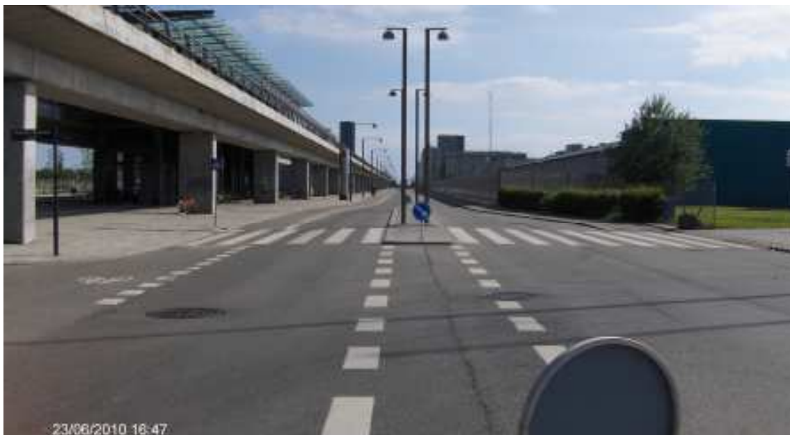
Foto 5: Fodgængerkrydsningen ved Bella Center set mod syd
