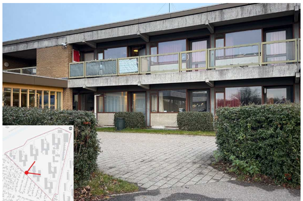
Figur 7-39 Billedet viser den vestlige facade ved den sydlige indgang til Bystævnet 27. Her går de karakteristiske bygningsdetaljer, i form af det synlige betondæk, glas gelænderet, de lyse brystninger og gule felter af mursten, igen. Foto COWI 2024.
