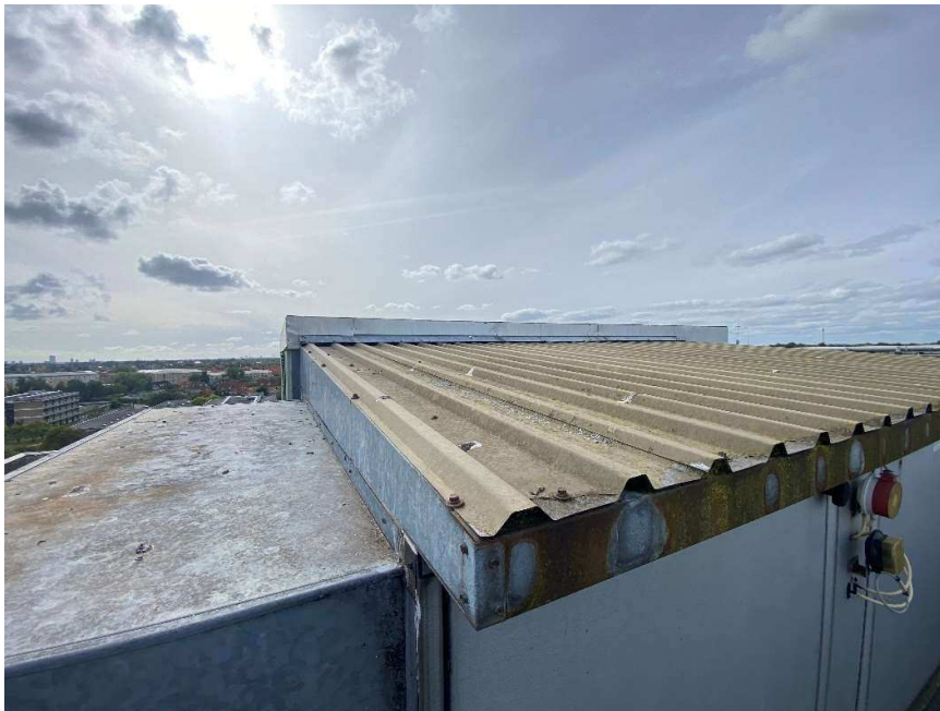
Figur 6. Der er ingen adgang for flagermus under tagpladerne.
