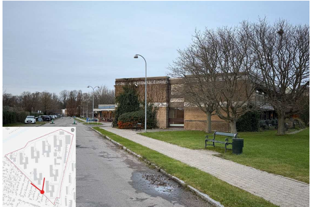
Figur 7-38 Billedet viser den eksisterende facade mod syd på bebyggelse Bystævneparken nr. 7. Betondækket er en del af facaden, som er en bygningsdetalje, som kendetegner hele bebyggelsen i Bystævneparken. Billedet viser også de gule murstensfelter, som også er et karakteristiske kendetegn i Bystævneparken. Foto COWI 2024.
