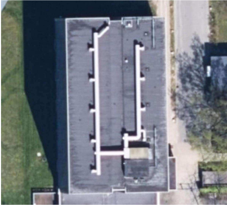
Figur 3. Taget med udluftningssystemet fra flyfoto.
