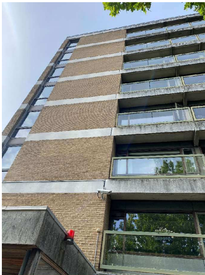
Figur 2. Bygning A set nedefra.
