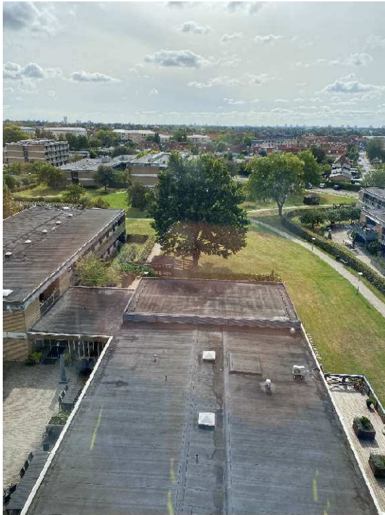
Figur 9. Et kig over de lave bygninger fra 7 etage af Bygning A.
