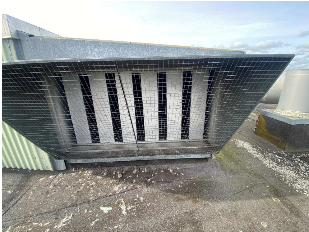
Figur 7. Det finmaskede trådnet tillader ikke flagermus eller fugle adgang til bygningen.
