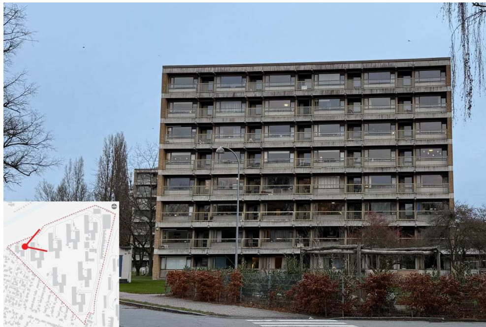
Figur 7-40 Billedet viser Bystævnet 23-24 set fra vest. Bebyggelsen er 8 etager høj, og de karakteristiske bygningsdetaljer, som kendetegner Bystævneparken, ses også i denne facade. De arkitektoniske kendetegn med vandrette betondæk, gavlene med de gule murstensfelter, gelænderet i glas, og tilbagetrækning af dørene i forhold til vinduespartierne går også igen. Foto COWI 2024.
